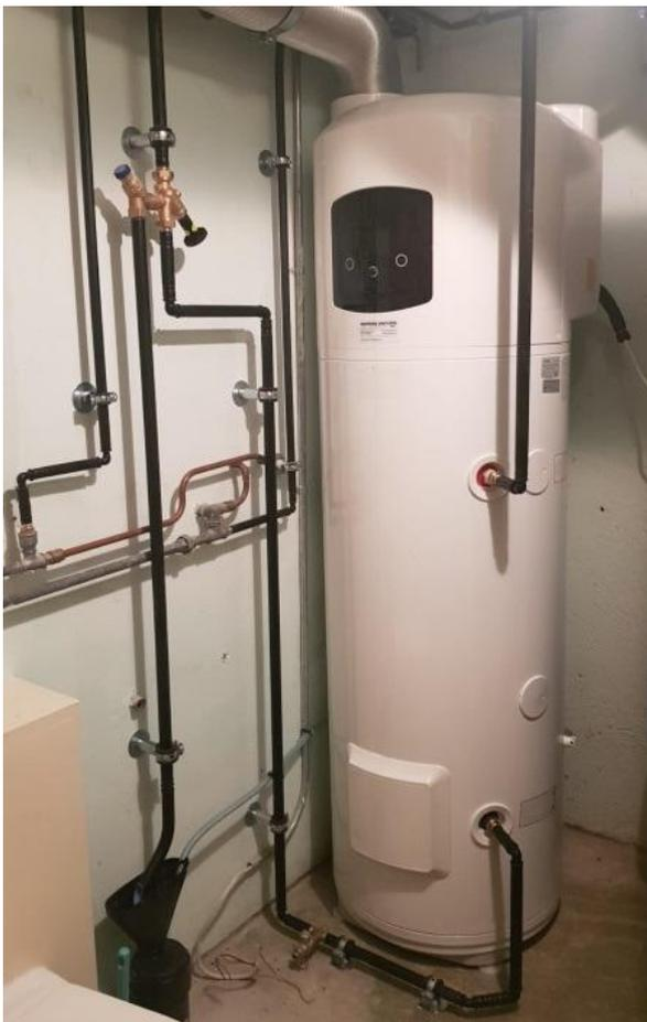
**Abbildung 1:** Beispiel einer Warmwasser-Wärmepumpe mit geführter Abluft.
